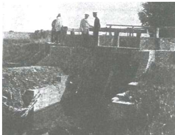
Пятигранный шлюз на Валуйском участке
