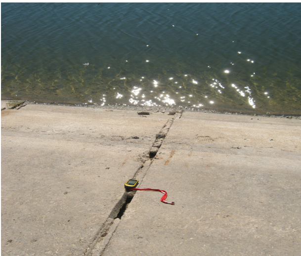
Фото 2 – Отсутствие гидроизоляционного материала заполнителя межпанельных швов и стыков в результате разрушения и прорастания растительности
