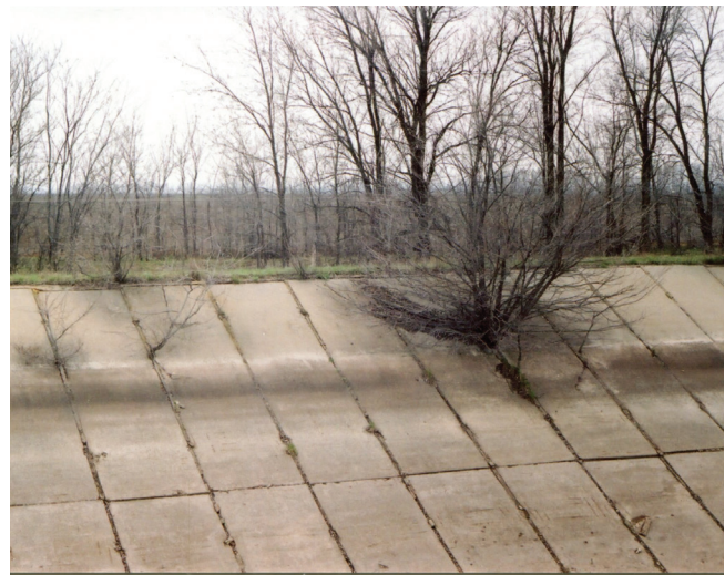
Фото 2 – Отсутствие гидроизоляционного материала заполнителя межпанельных швов и стыков в результате разрушения и прорастания растительности
