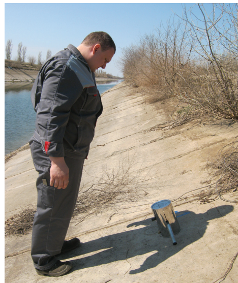
Фото 1 – Определение водонепроницаемости бетонно-пленочной противофильтрационной облицовки на Большой Волгоградской оросительной системе
